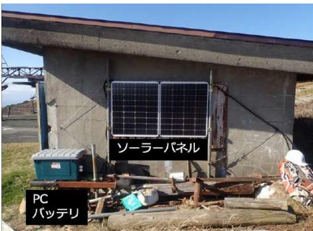
図 3 インターバルカメラの制御部と電源設備の設置状況。
