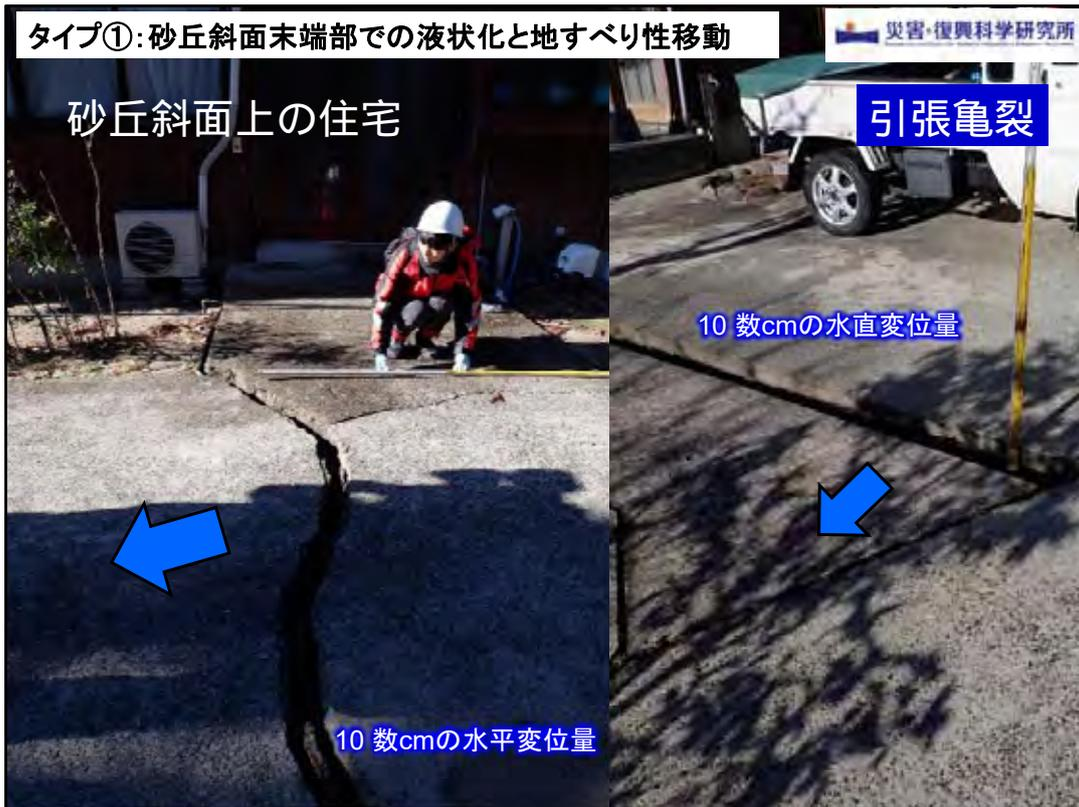
寺尾地区の宅地での引張亀裂の例です。一般的な地すべりのように大規模に移動するのではなく、10数cmの水平変位と10cm程度の垂直変位を持った亀裂が、数列認められ、傾斜方向に移動しているようすが認められます。なお、このような移動した宅地地盤では、噴砂は認められません。
