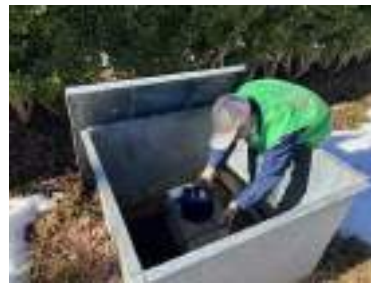
震度計感部の点検 (上越市吉川区)
