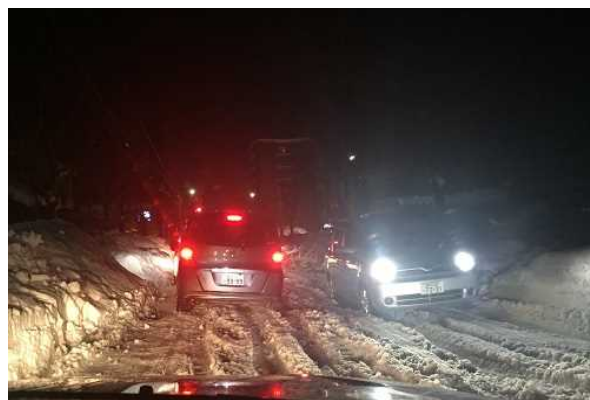
写真-1 圧雪轍掘れが発生した道路状況
