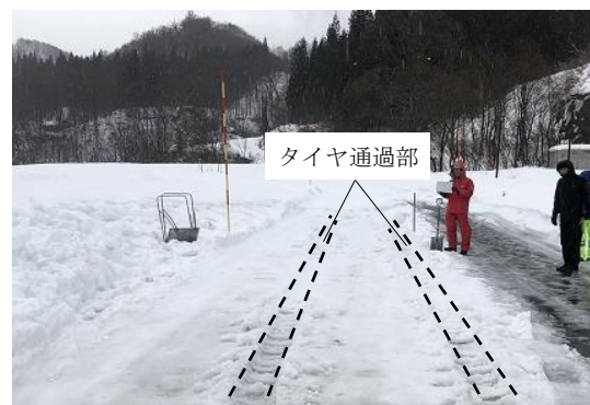
写真2 轍掘れ走行試験の状況
