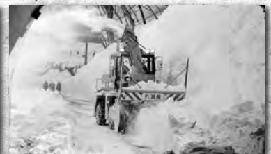
新潟県から出動した ロータリー除雪車の活躍
