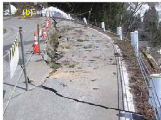
写真 2-1 新潟県十日町市松之山区坪野における尾根部の変状（a：全景，b：近景）
