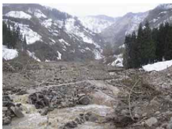
写真5-1 長野県栄村北信東入沢川の崩壊と土石流堆積物
