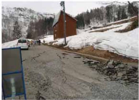
写真6-2 長野県栄村北信青倉の変状箇所 (地すべり：路面)
