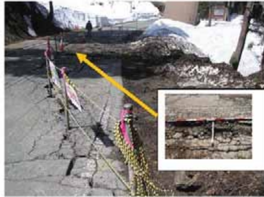
写真 2-2 新潟県十日町市松之山区坪野におけるコミュニティセンター北側の変状
