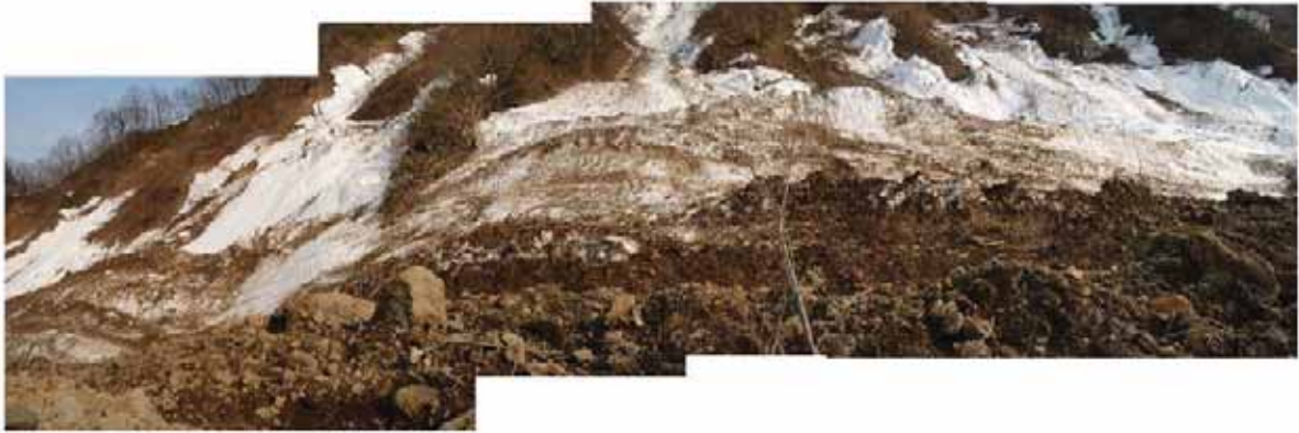
写真4-5 新潟県津南町辰ノ口トヤ沢の崩壊の流下痕跡
