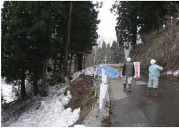
写真6-1 長野県栄村北信青倉の変状箇所 (切土と路肩)
