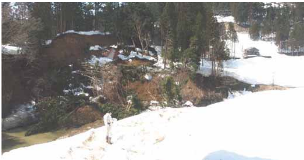
写真1 新潟県十日町市松之山区赤倉（大畑地区）の崩壊
