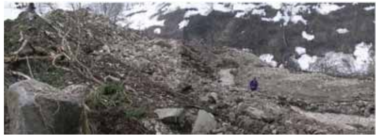
写真5-2 長野県栄村北信東入沢川の温泉施設脇の土砂堆積状況
