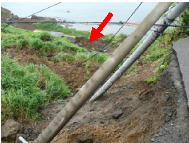
写真-3 柏崎市米山地区。聖ヶ鼻の北東側の斜面で発生した地すべり。撮影者の立つ道路が矢印の位置まで滑落した
