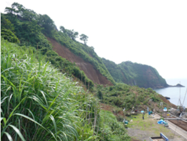
写真-1 柏崎市青海川地区。ＪＲ青海川駅の斜面崩壊
