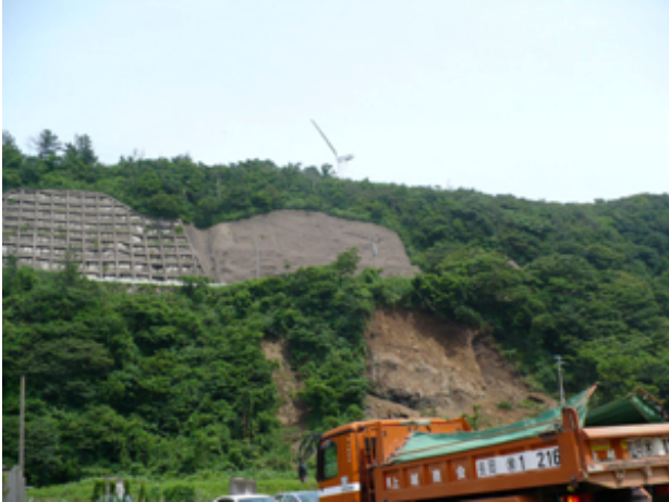
写真-3 柏崎市青海川地区。斜面防止施設のある斜面（上方）と施設のない斜面（下方）
