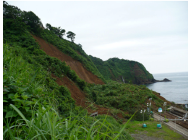
写真－１２ ＪＲ青海駅近くの斜面崩壊（柏崎市青海川）
