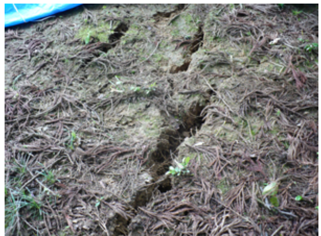
写真－１０ 民家裏手の斜面頂部の亀裂（刈羽村赤田北方地内）
