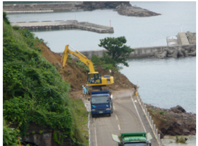
写真－１４ 柏崎市笠島地内で発生した斜面崩壊
