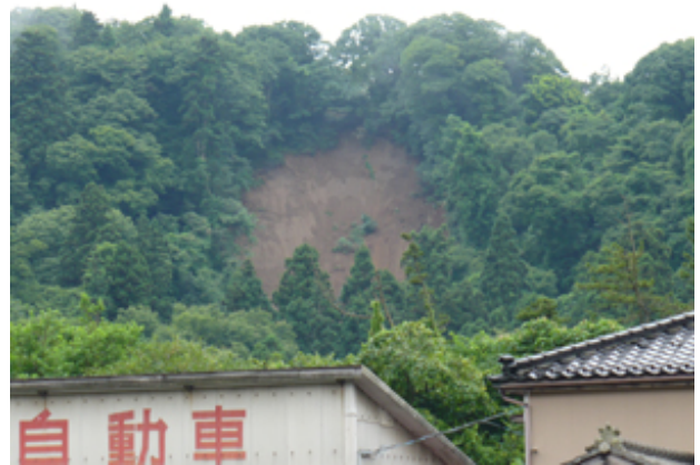
写真－６ 宮川神社裏手の斜面崩壊（柏崎市宮川地内）
