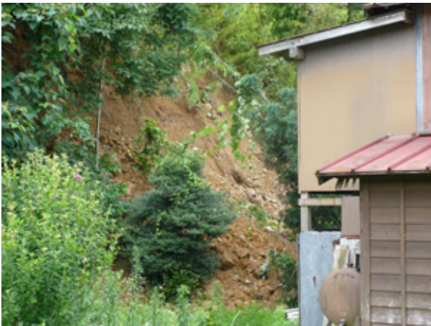
写真－７ 民家裏手の斜面崩壊（柏崎市花田地内）
