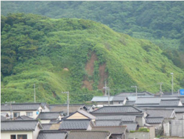
写真－５ 柏崎市椎谷地内の斜面崩壊
