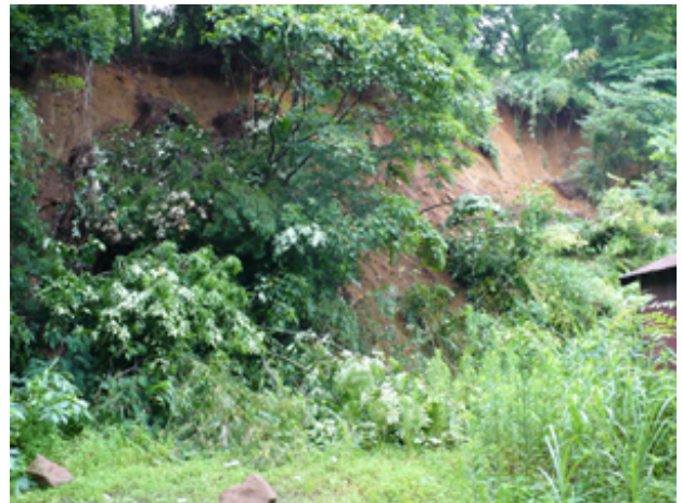
写真－８ 民家裏手の斜面崩壊（刈羽村西元寺地内）
