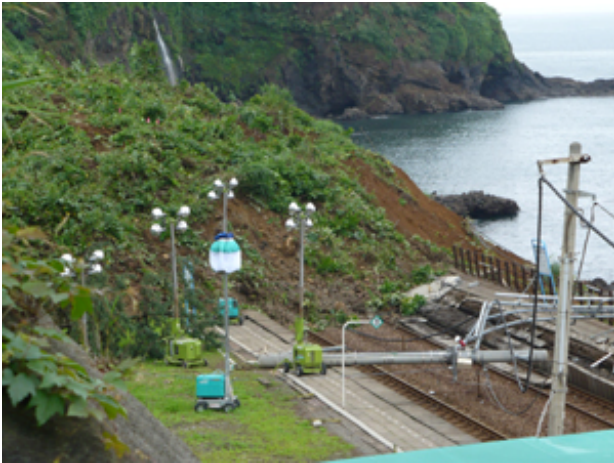
写真－１１ 崩壊土砂による線路の埋積（ＪＲ青海駅近く。柏崎市青海川）
