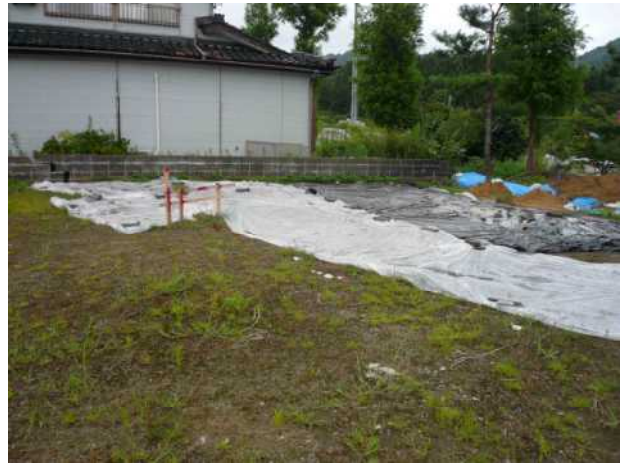
写真 6 ③地点における開口亀裂と住家の損壊.
