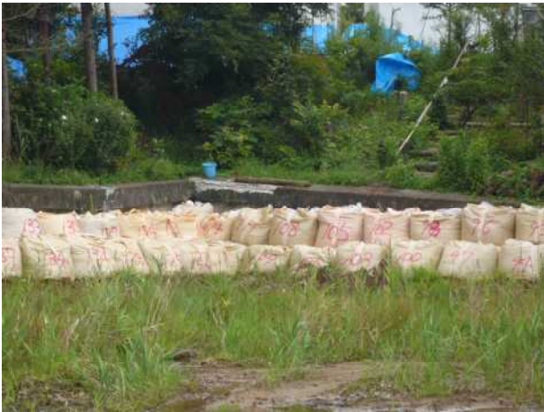
写真 5 ②地点の斜面末端におけるコンクリート擁壁の損壊.
