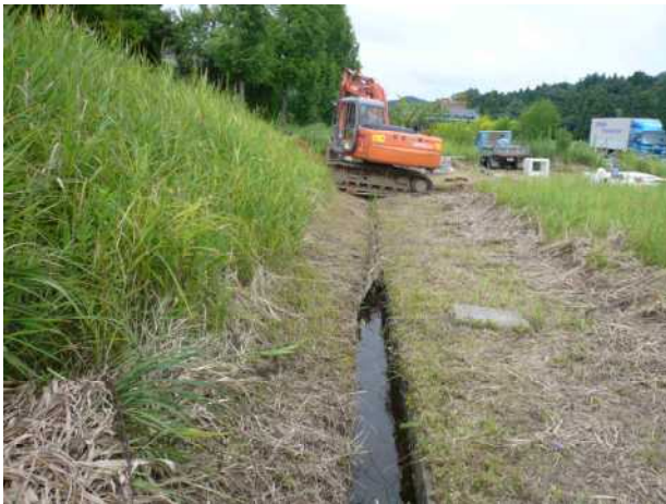
写真 7 ③地点の斜面末端部における圧縮変形.
