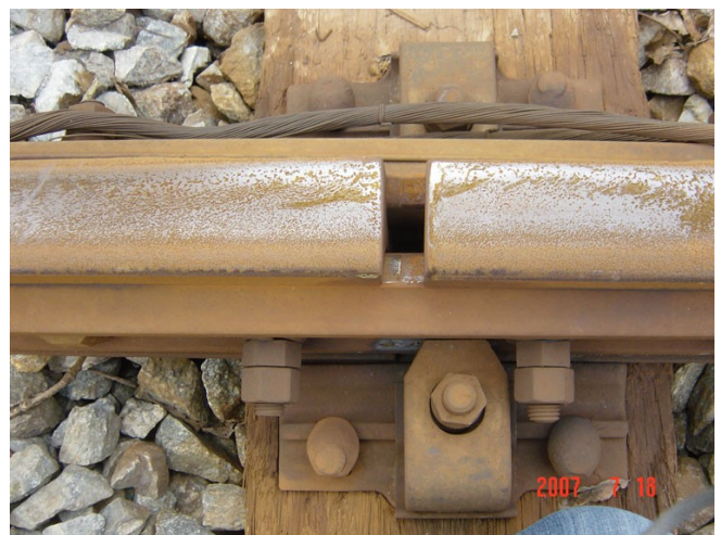
↑ ⑧⑦同所 線路と線路の継ぎ目がずれている。線路と枕木を固定する部分も右側にずれている。
