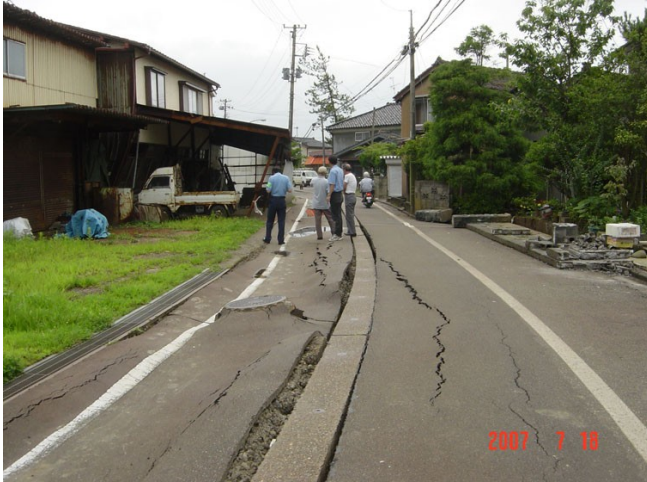
↑①山本 旧河道上の道路の陥没。道路の中央線(消雪パイプ)から左が旧河道側。
