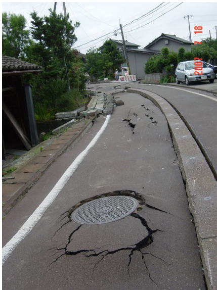
↑①山本 旧河道上の道路の陥没。道路の中央線(消雪パイプ)から左が旧河道側。
