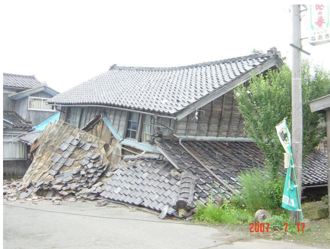
↑⑥浜忠 全壊した古い二階建ての建物。一階部分は完全に倒壊。
