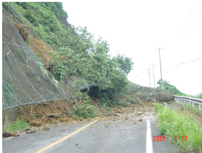
↑②①のズーム 表層崩壊による道路の遮断。崩壊したのは椎谷層である。
