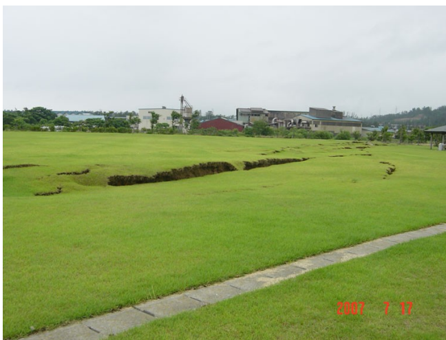
↑ ⑨松波、鯖石川改修記念公園 長さ50m以上の亀裂。多くがN50E方向に走っている。亀裂の高さ・深さともに最大約45cm。液状化の発生する亀裂と発生しない亀裂があった。
