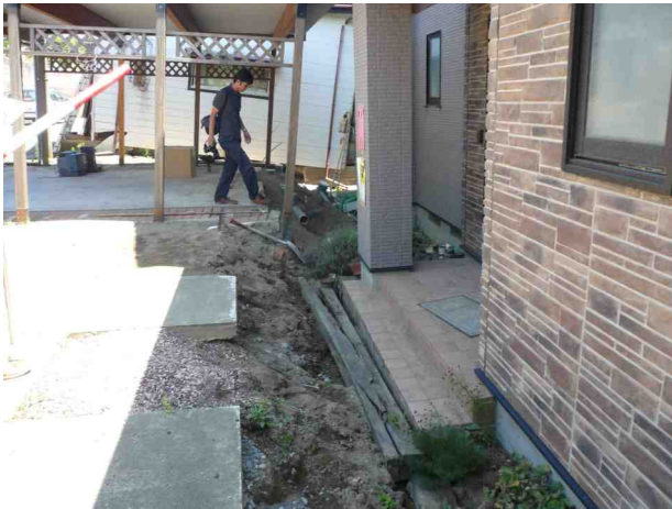
写真 3 B地点における地すべりの開口亀裂.
