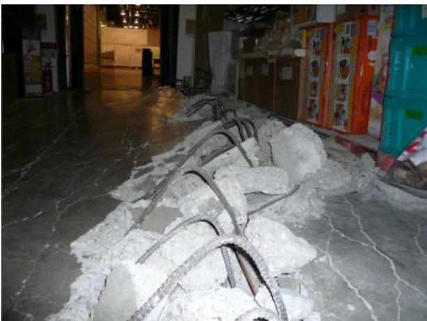
写真 11 大型ショッピングセンターのフロアの圧縮変形.
