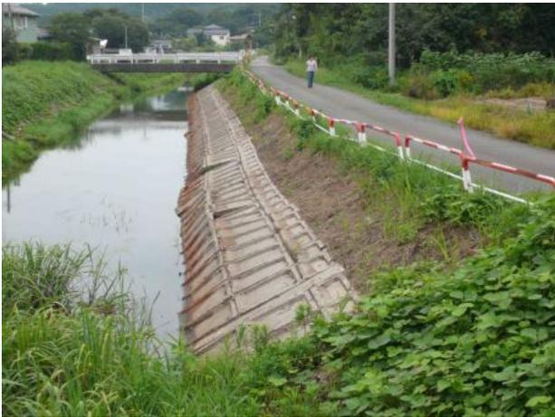
写真 9 下高町の砂丘緩斜面末端に見られる河川護岸のはらみ出し.
