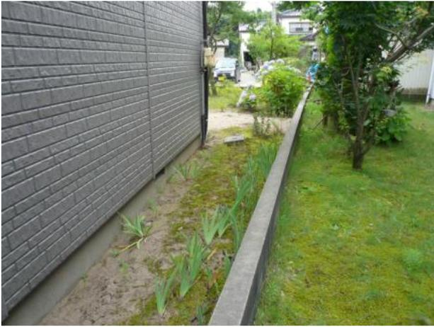
写真 1 正明寺西部の住家にみられる噴砂と家屋の不等沈下.
