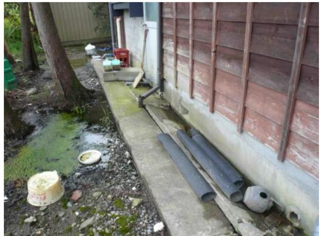
写真 6 正明寺北部の砂丘斜面末端の住家の不等沈下と湧水.
