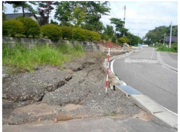
写真 4 正明寺北部の道路に見られる開口亀裂.
