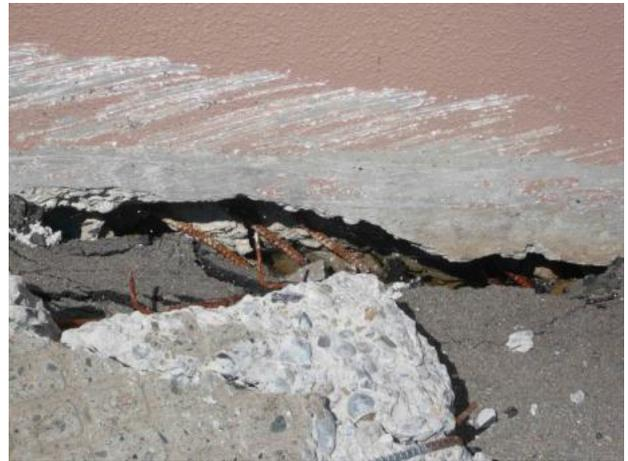
写真 10 大型ショッピングセンターの基礎の損壊. 地盤が相対的に右に移動している.
