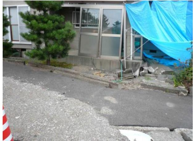
写真 8 下高町の砂丘緩斜面の開口亀裂にともなう住家の変形.
