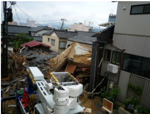
東本町（１） 左写真：左奥（傾斜地下側）に向けて家がずり落ちている 右写真：増改築したところのつなぎ目から倒壊している
