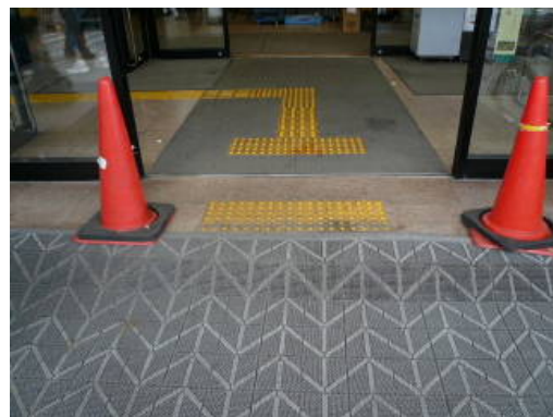
右写真：高齢者がケガをした S C 入口の段差（東本町 1 の良食生活館）
