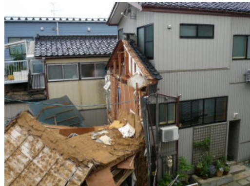
東本町（１） 左写真：左奥（傾斜地下側）に向けて家がずり落ちている 右写真：増改築したところのつなぎ目から倒壊している
