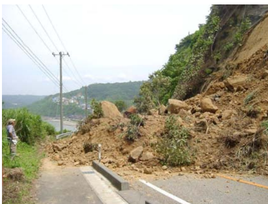
写真 1: 観音崎の斜面崩壊現場
