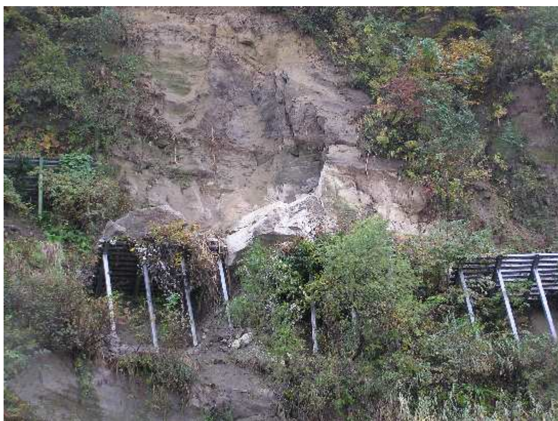
写真 3 十日町市市之沢付近（調査地点 3）
