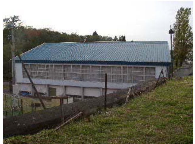
写真3 西側斜面際(3号館から下の体育館を見る)
