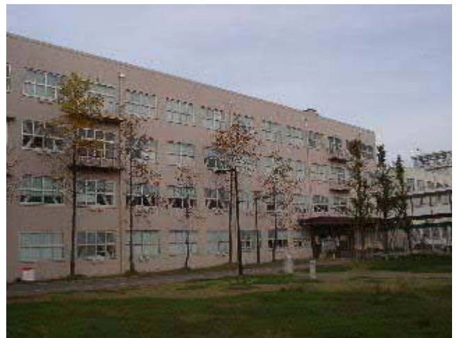
写真 1 6 4号館 (K プレース補強)
