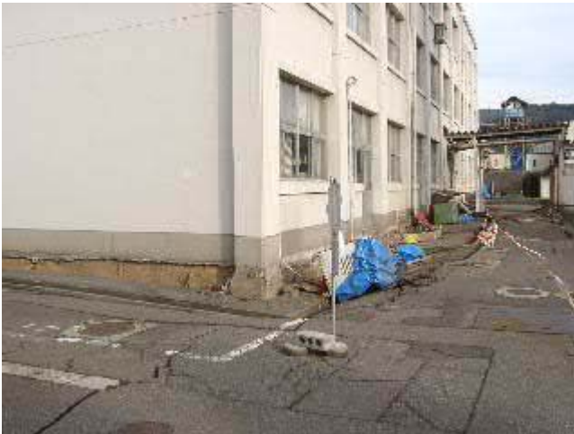
写真7 3号館（北西より）
