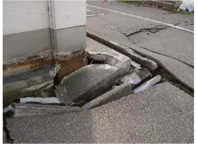
写真8 3号館の北西隅角部（斜面の際）
