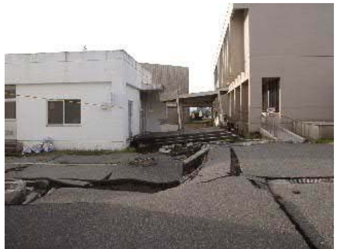
写真4 西側斜面際(3号館の横の建物(名称不明))
