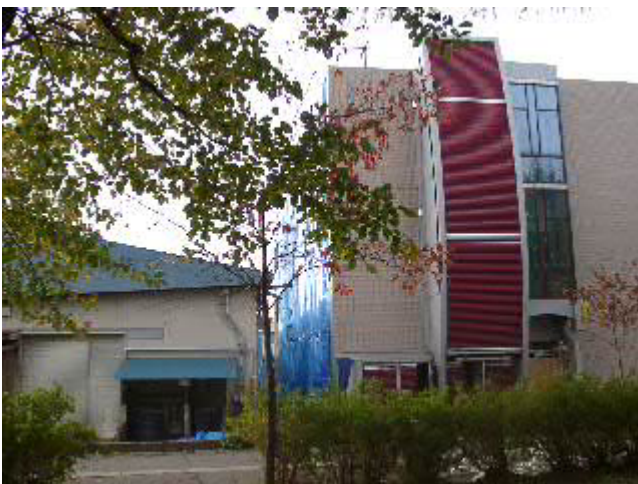
写真19 5号館(右)を南からみる。ブルーシートで覆われている)
