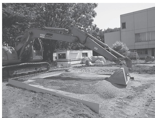
図3 法面バケットによるCB層の敷設
