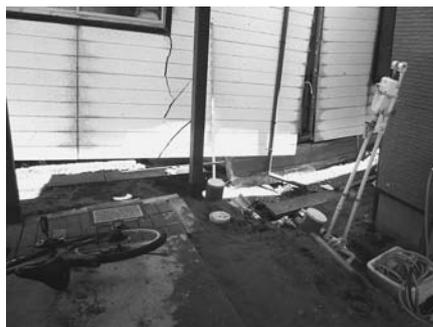
写真3-4 地すべりの開口亀裂と建物の変状 (B地点)。
