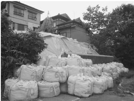
写真6-2 ①地点におけるコンクリート擁壁の損壊
