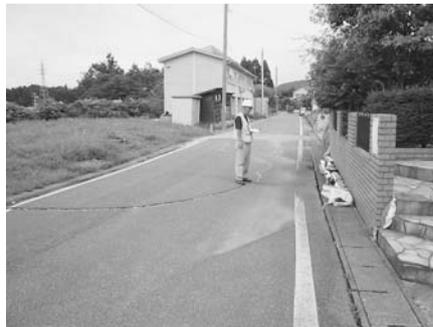
写真6-5 ④地点における円弧状の開口亀裂
