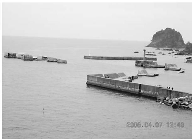
写真－2 水津漁港防波堤の被害
