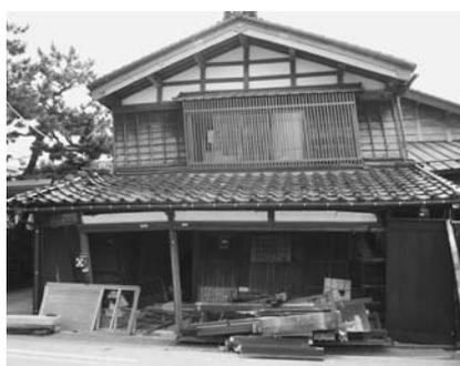
写真1-1 木造住家（直接基礎タイプ）の大破
