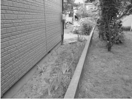
写真5-1 正明寺西部の住家にみられる填砂と家屋の不等沈下。
