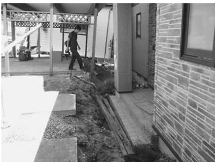
写真3-2 地すべりの開口亀裂と家屋の移動 (B地点)。
