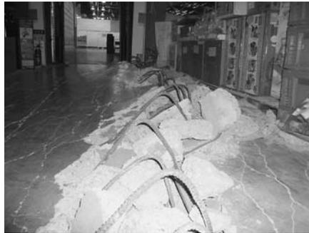
写真5-6 大型ショッピングセンターのフロアの圧縮変形。
