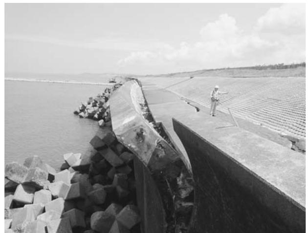
写真－5 防潮護岸工の倒壊
