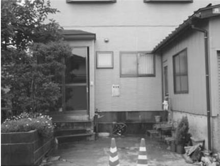
写真2-2 流路部分の家屋の不等沈下。玄関引き戸枠がゆがんでいる。
