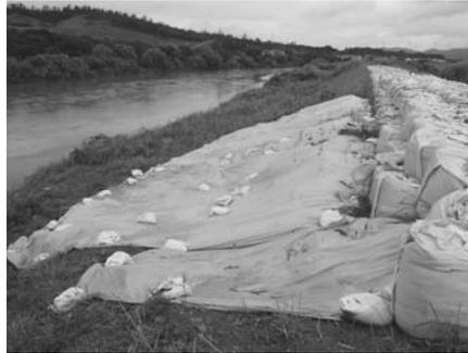
写真2-4 旧流締め切り部分に相当する鯖石川左岸の堤防の沈下。
