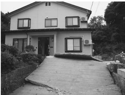
写真4-3 砂丘斜面末端部の地すべりによる宅地の押し出し。
