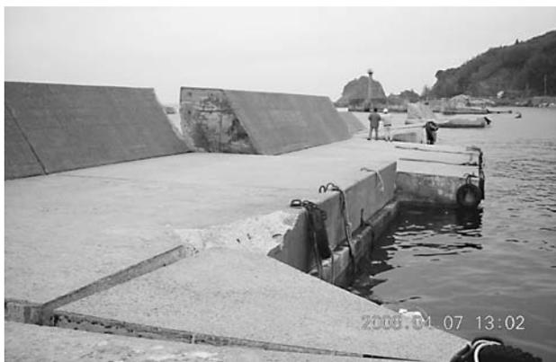
写真－3 水津漁港防波堤の被害
