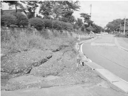
写真5-3 正明寺北部の道路に見られる開口亀裂。
