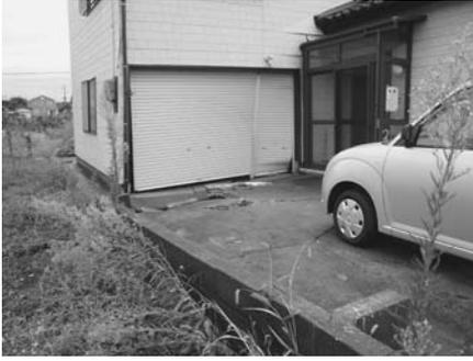
写真2-1 流路に相当する地盤の沈下によって大きな被害を受けた住家。写真左側が開口亀裂を伴い沈下した。亀裂は建物を横断している。
