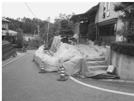
写真6-6 ⑤地点のコンクリート擁壁の損壊
