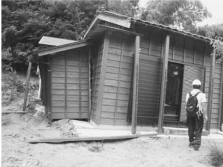
写真4-2 砂丘斜面末端部の地すべりによる家屋の変形。
