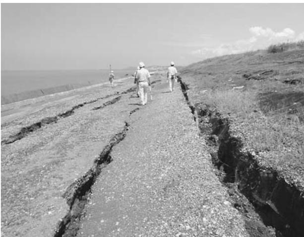
写真－4 防潮護岸工背後の土塁状盛土の開口亀裂
