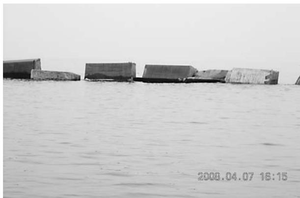
写真－4 北小浦漁港防波堤の被害
