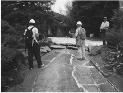
写真4-1 砂丘斜面末端部の地すべりによる宅地の押し出し。
