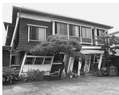
写真1-4 木造住宅（直接基礎タイプ）の大破
