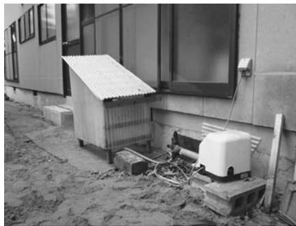
写真4-6 2004年中越地震時の基礎沈下の補修、再沈下している。
