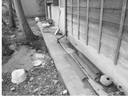
写真5-4 正明寺北部の砂丘斜面末端の住家と不等沈下と湧水。
