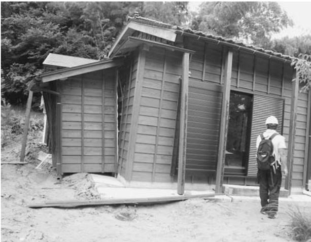
写真－2 刈羽・稲場地区での液状化・地すべりによる建物被害
