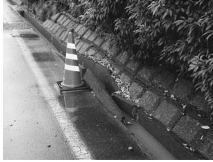
写真2-3 旧流路部分に相当する箇所での道路の変状。旧流路部分が沈下したため中央で圧縮変形が起きている。
